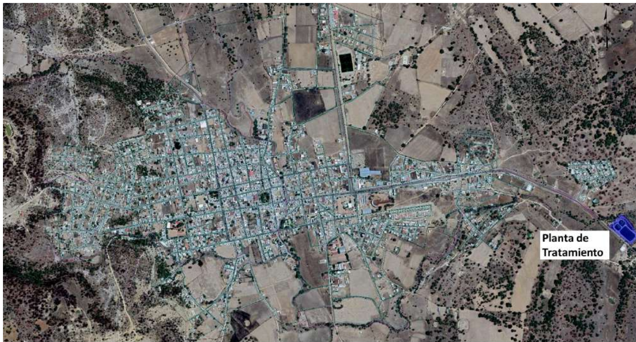
IMAGEN 14. LOCALIZACIÓN DE LA PLANTA DE TRATAMIENTO DE MONTE ESCOBEDO
