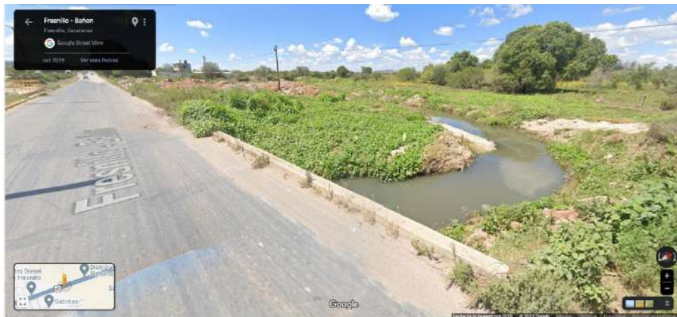
Figura 8. Vista del desfogue del agua que se acumula en El Vergel al otro lado de la carretera Fresnillo – Bañón
