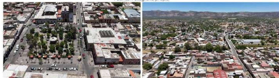
Ilustración 4. Zona Centro del municipio de Villanueva Fuente: Fotografía propia
